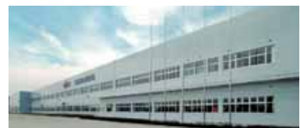
Fujitsu General Central Condizionatore d'aria (Wuxi) Co., Ltd. (Cina).
