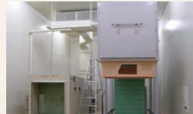
اختبار تدفق الهواء Airflow testing
